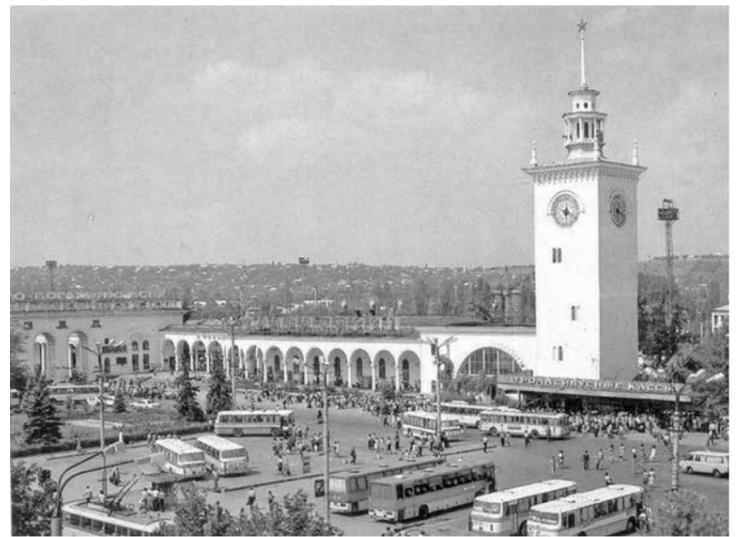
света, больше трех метров, длина минутных стрелок — два метра, часовых — полтора метра. Возле каждой цифры на циферблате установлены знаки зодиака, каждый из которых размером более метра. Часы механические, от 1-го Московского часового завода, приводятся в движение гириями, вес которых 250 килограмм. Гири «подтягиваются» вокзальным механиком раз в десять дней.
