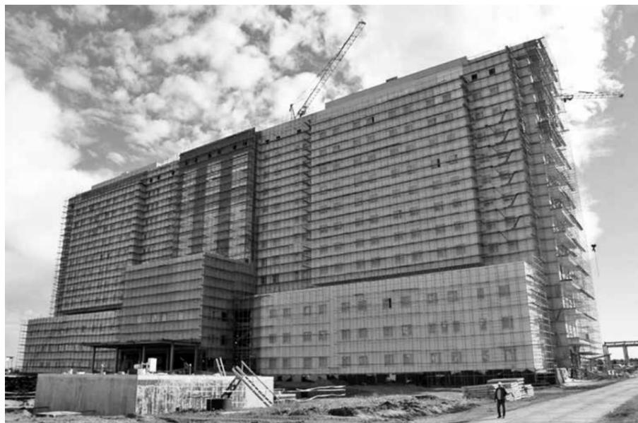
В данный момент на объекте ведется отделка фасада, внутри здания осуществляется монтаж инженерных систем, готовится установка лифтового оборудования, проектировщики продумали и предусмотрели рациональное расположение всего необходимого оборудования, аппаратов, приборов. К этим позициям прокладываются силовые кабели, заземление и другие необходимые коммуникации.
